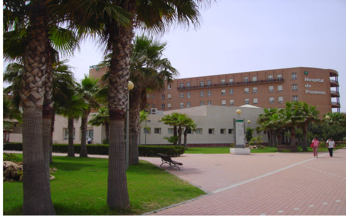
Fachada del Hospital de Poniente, en el municipio de El Ejido.
